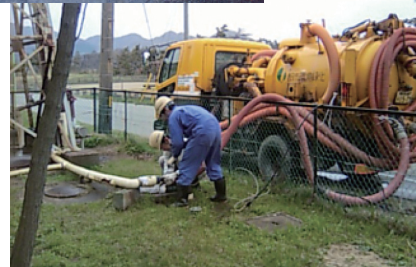
温泉配管洗浄
