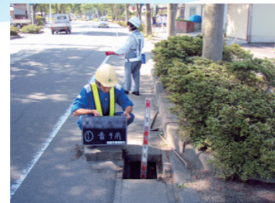
道路側溝清掃
